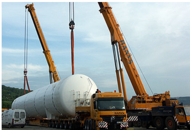
LNG-Terminal construction site ( http://www.chart-ferox.com/ )
